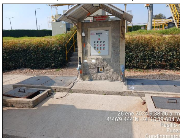
Ilustración 4. Tanque de almacenamiento y tablero de bombas
