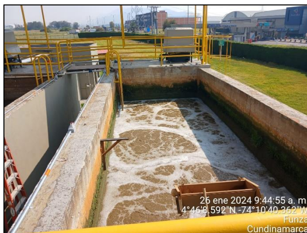
Ilustración 7. Reactores lodos activados
