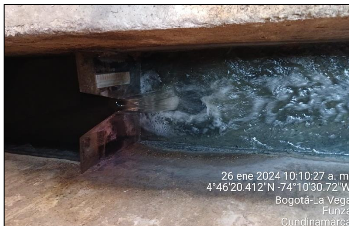
Ilustración 15. Canaleta de medición de caudal de ARnD
