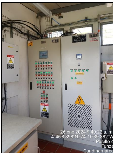
Ilustración 14. Tablero de control sistema de automatización
