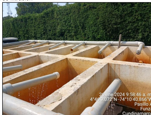
Ilustración 9. Sistema de filtración
