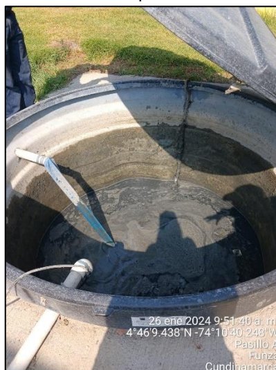
Ilustración 11. Espesadores de lodo
