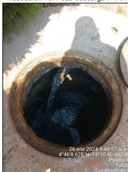
Ilustración 10. Pozo descarga PTAR
