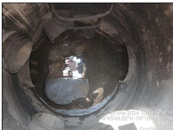
Ilustración 26. Pozos de alcantarillado pluvial con agua
