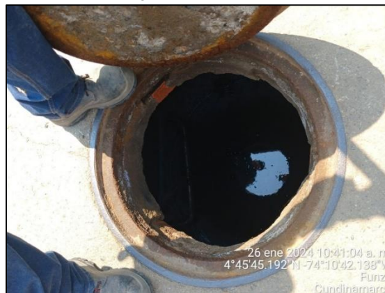
Ilustración 26. Pozos de alcantarillado pluvial con agua
