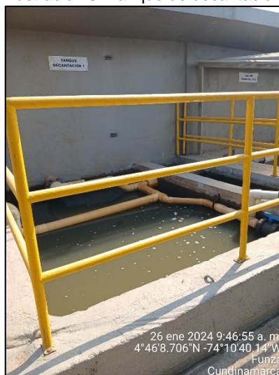
Ilustración 8. Tanque de decantación
